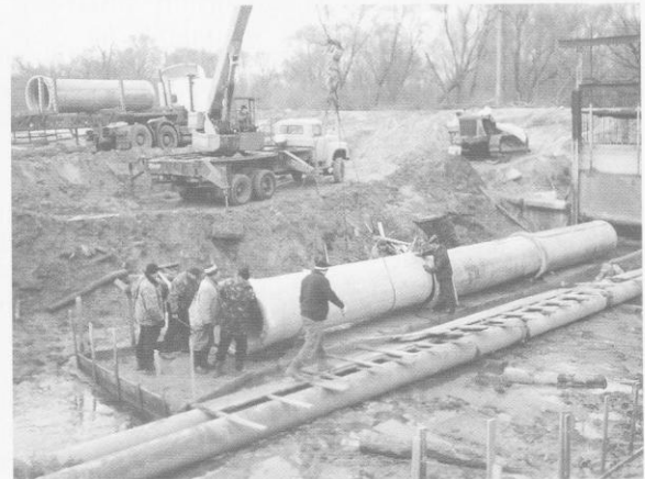
Капітальний ремонт водоскидної споруди в с.Голубівка (Середино-Будський р-н)
